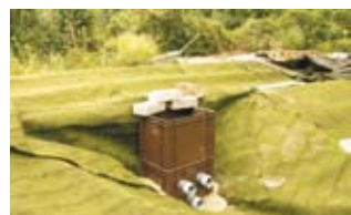
Einbau vor der Damm-Durchführung
