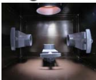
Blick in den Schacht: 3 Schieber regeln die jeweiligen Ansaugmengen, die große Öffnung führt in den Filtergraben
