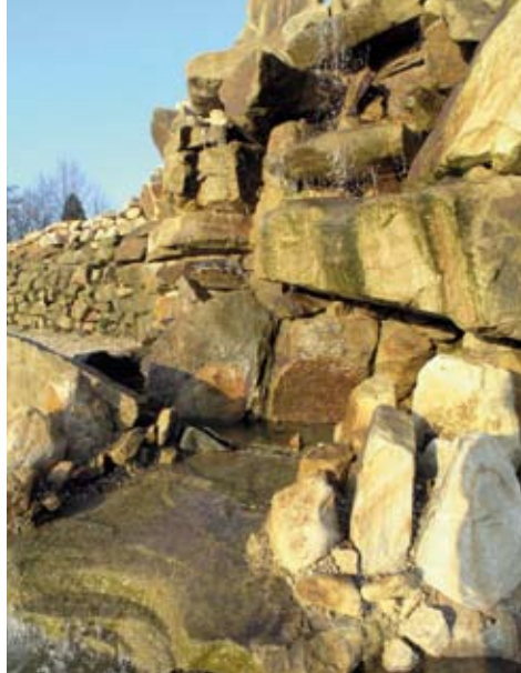
Großanlagen wie dieser Wasserfall im Natura-Cart -Park brauchen schon aufgrund ihrer Höhe viel stärkere Pumpen - aber auch das läßt sich optimieren.
