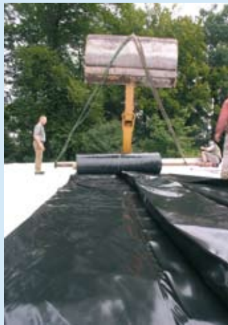
23 Auf großen Dächern hilft Maschineneinsatz, hier reicht ein Bagger 800 m 2 Folie auf das Hallendach.
