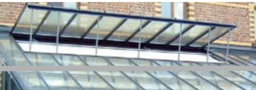
Die automatische Schattierung sorgt immer für ideale Lichtverhältnisse, die großen Lüftungsfenster verhindern automatisch einen Hitzestau
