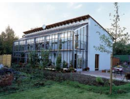
Die Verglasung macht das Sonnenlicht zur Beheizung des Hauses nutzbar.
